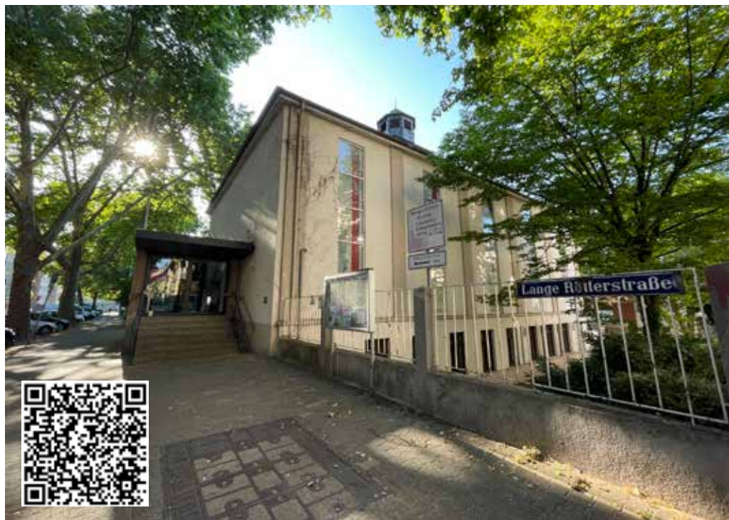
Die Melanchthonkirche wird umgebaut. Wir informieren Sie regelmässig über unsere Webseite – Melanchthonkirche wird umgebaut – Bautagebuch. Foto: Judith Natho
